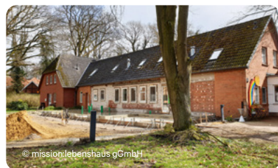
Es ist noch viel zu tun: Hier entstehen die neuen Gastzimmer
